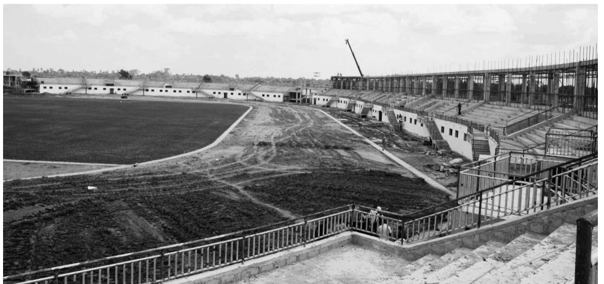
Le chantier du stade omnisports de Djambala
