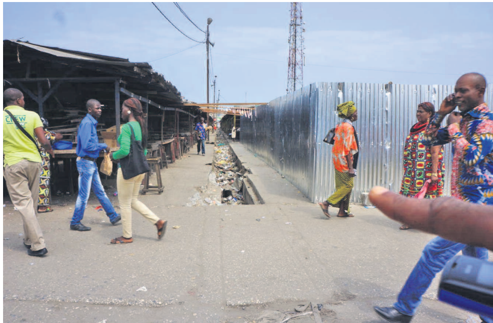
L'une des canalisations où des travaux doivent être exécutés
