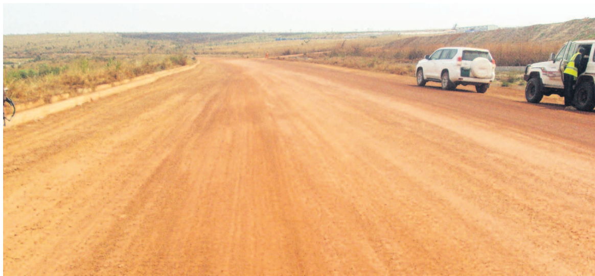
Une partie de la route terrassée près de Mindouli
