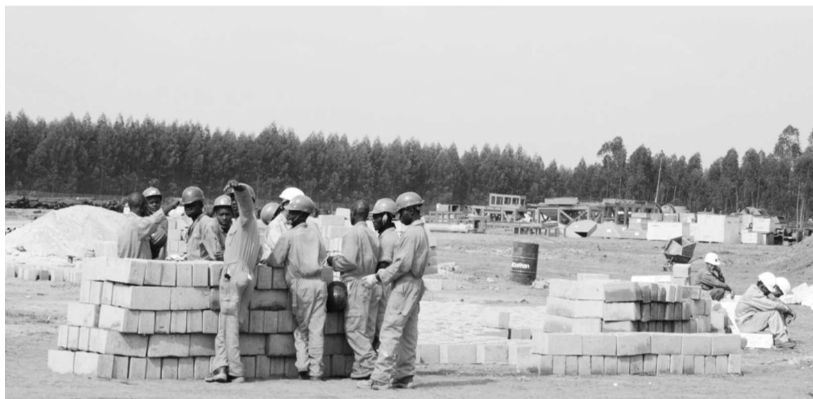
Les ouvriers sur le site du chantier
