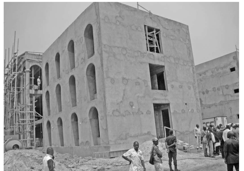
Le bâtiment en construction du Tribunal d'instance de Ouenzé et Talangai
