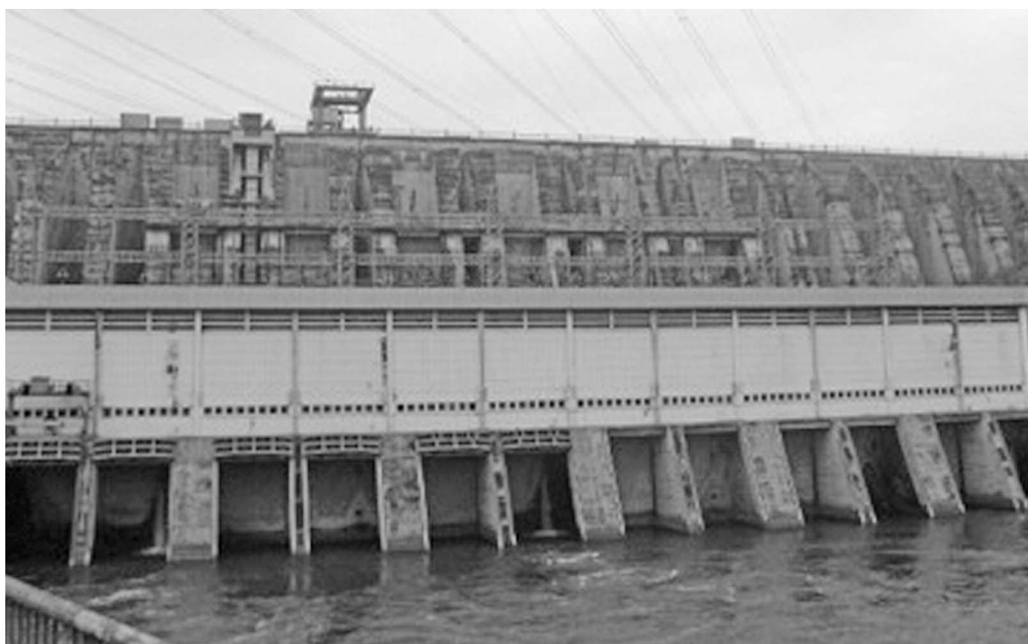
Vue du barrage d'Inga dans le Bas-Congo
