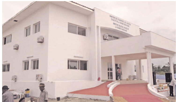
Le bâtiment du siège de la délégation maritime de Madingo-Kayes (© Adiac)
