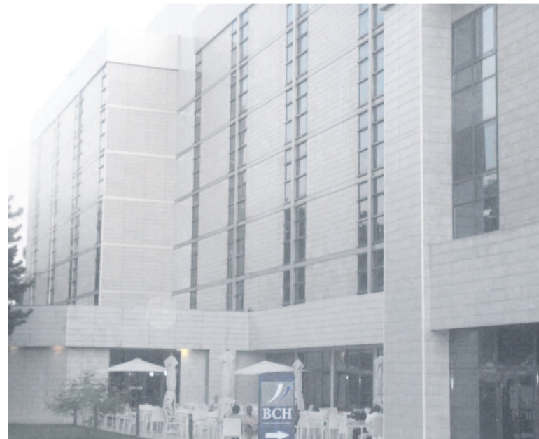
Une façade du Ledger Plaza Maya Maya
