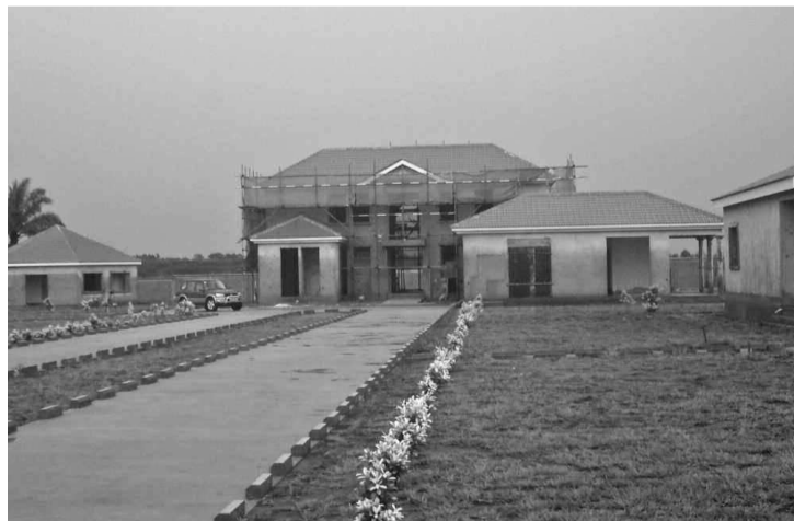
Une vue du nouveau palais en construction
