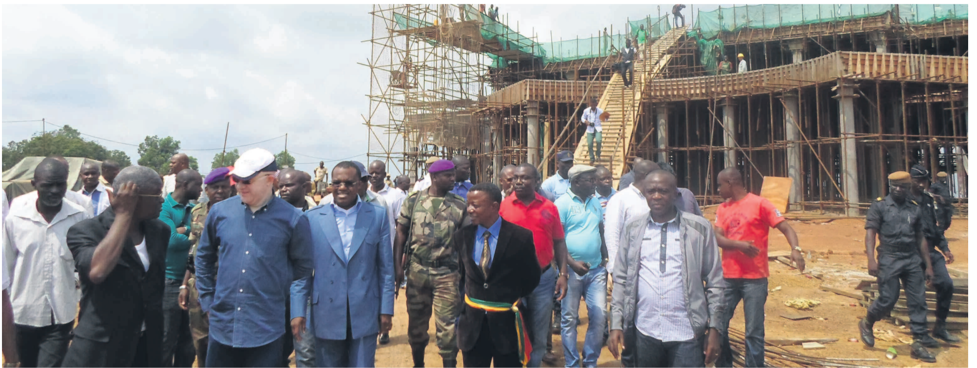
Le ministre Thierry Mougala et Edgard N'Gusso lors de la visite des chantiers
