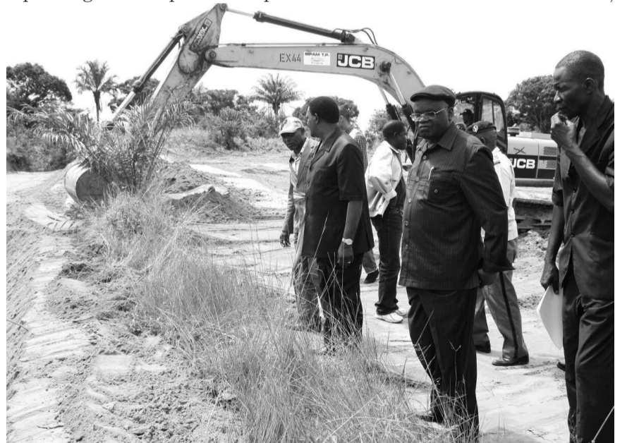
Le ministre Emile Ouosso sur le site du traitement de l'érosion
