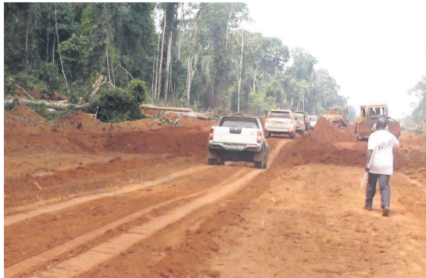
Une partie de la route remblayée (© DR)
