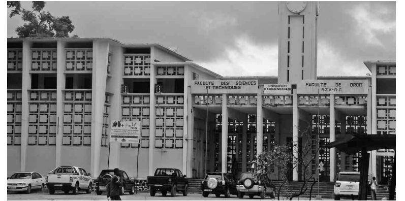
La façade principale
