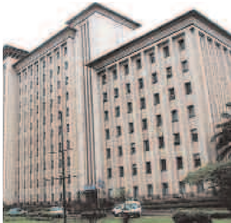
L'immeuble de la société commerciale des transports et des ports (SCTP), ex-Onatra
