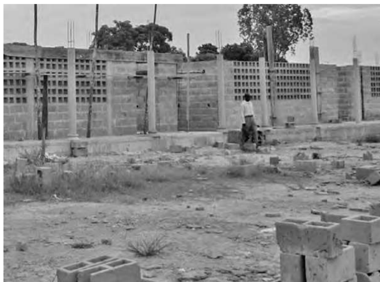
des salles réhabilitées
