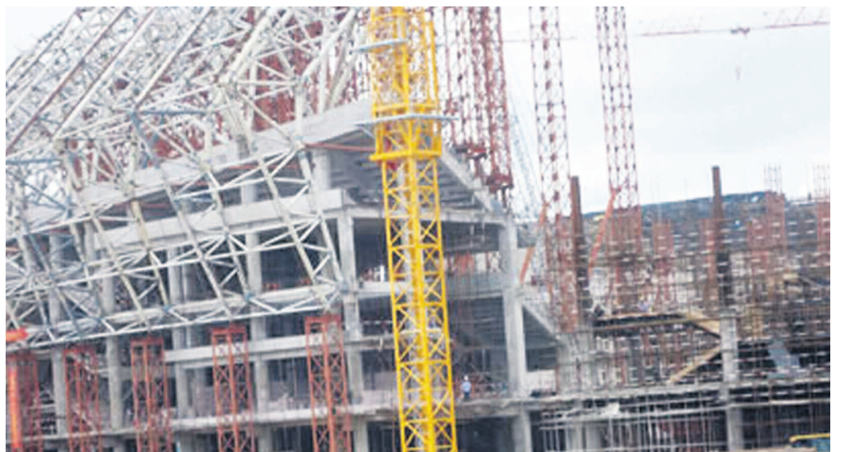
Vue du complexe sportif de Kintélé en construction
