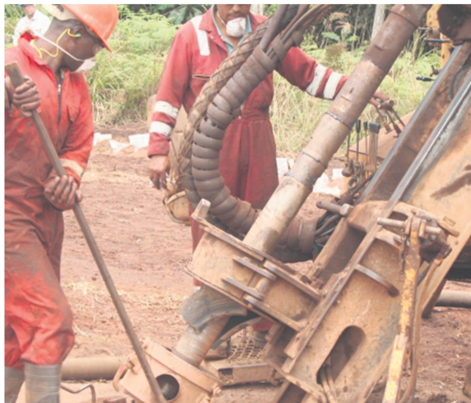
Une opération de forage de fer à Zanaga
