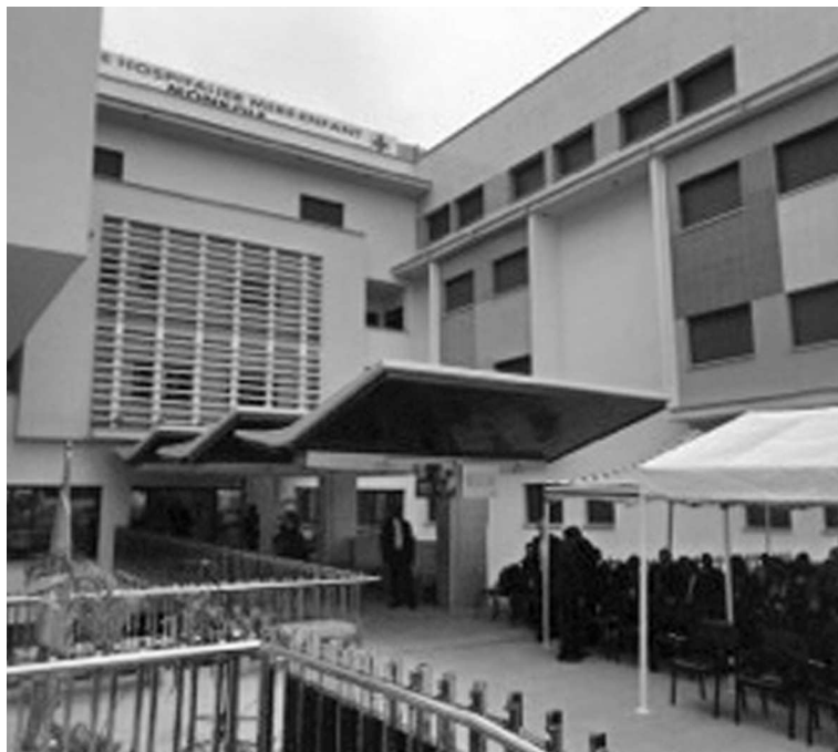
Vue du bâtiment abritant le Centre hospitalier Mère et Enfant Monkole
