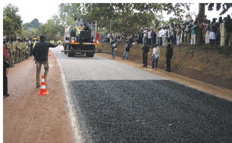
Une opération d'application du Probase à Mapati, dans le département de la Lékoumou/photo DR
