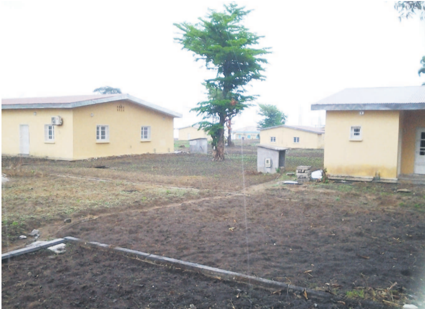
Une vue de la base vie de Tsiélampo
