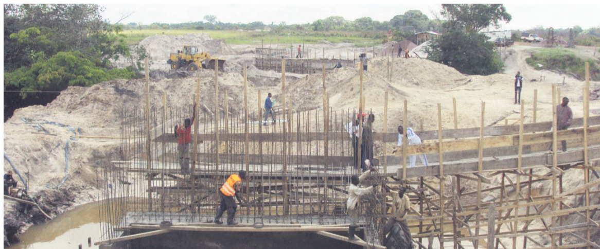
Les ouvriers et techniciens à pied d'œuvre sur le chantier ; crédit photo Adiac
