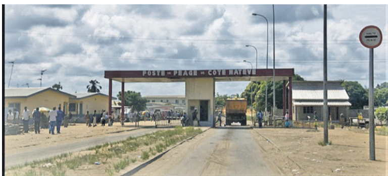
Poste de péage de Côte matève / crédit photo DR
