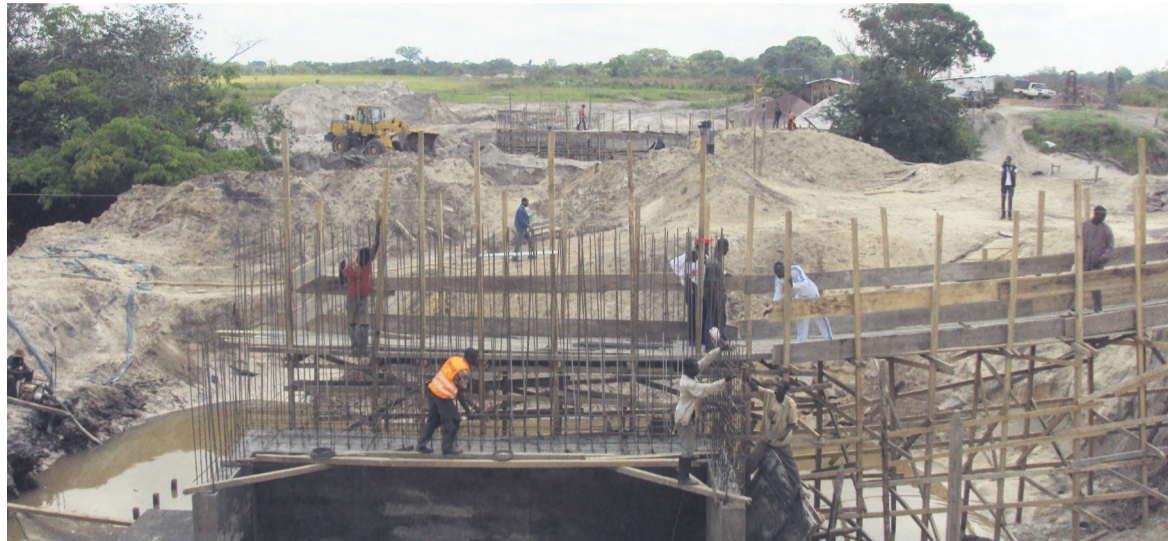
Les travaux du pont sur la rivière Djouké photo Adiac
