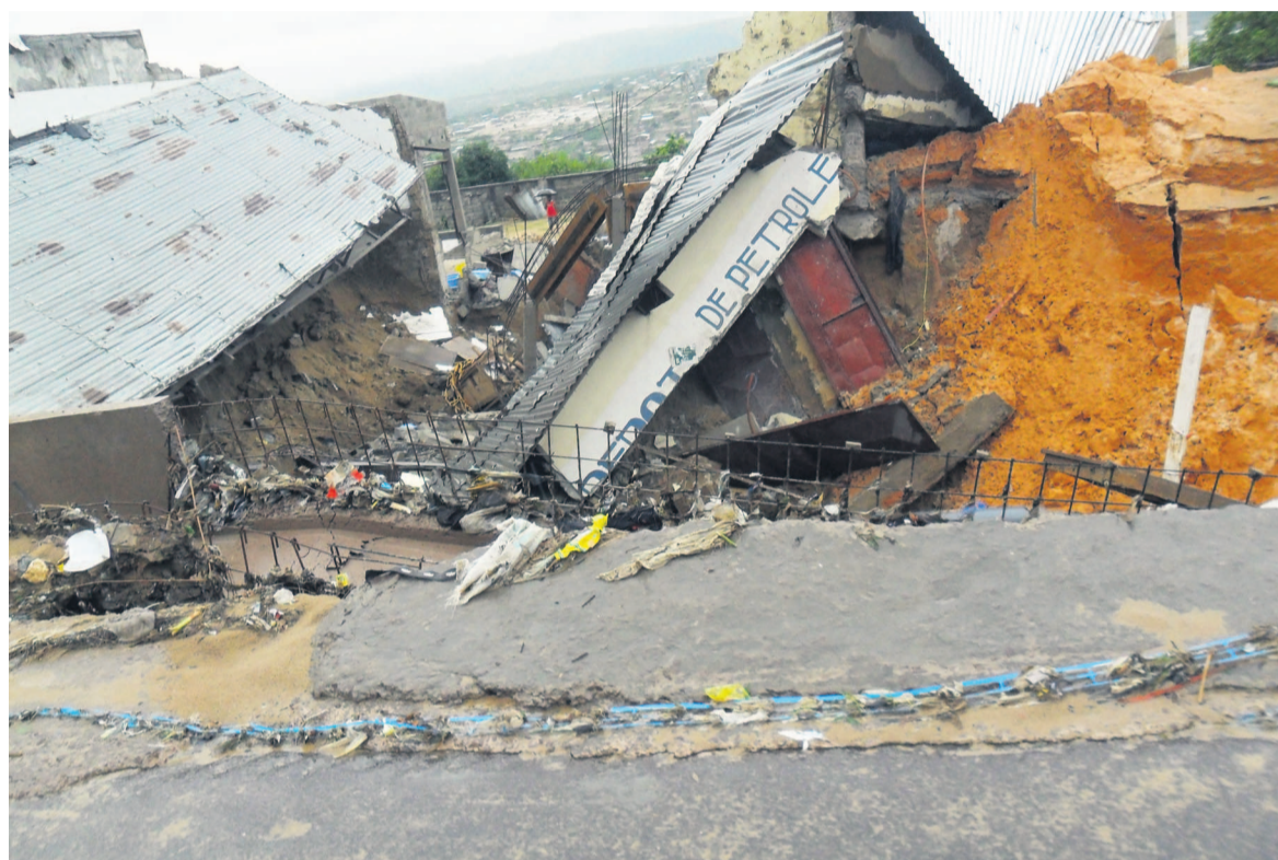
La route nationale 2, à hauteur de l'arrêt Manguier à Massengo
