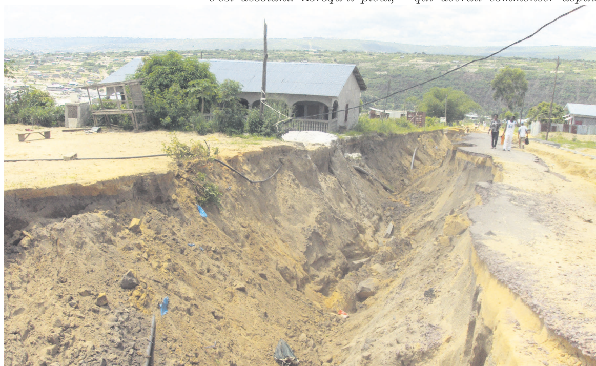
L'érosion menaçant la route de la station terrienne
