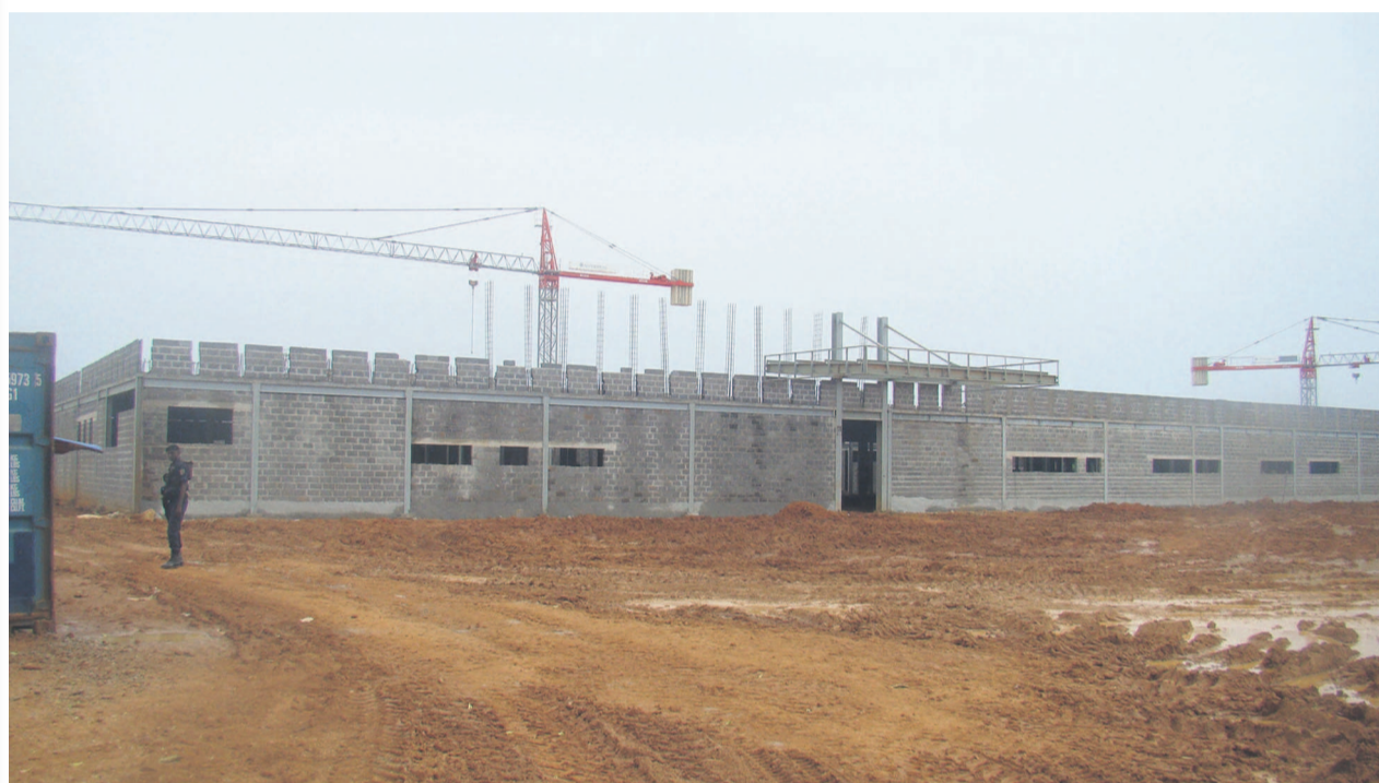
Le chantier de l'hôpital général de Ouesso
