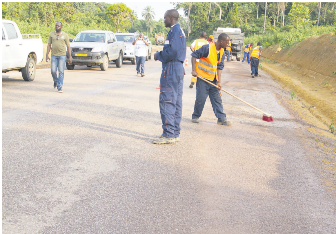
Vue d'une route couronnée en produit « 3 S » sur l'axe Mapati-Zanaga, dans la Lékoumou.
