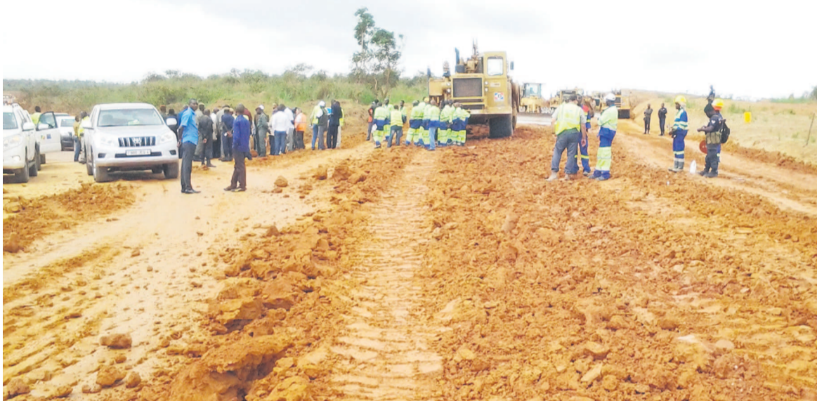
Les travaux sur l'axe routier Kinkala-Mindouli
