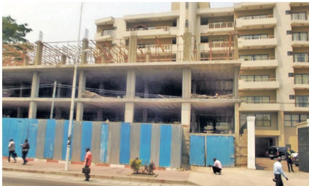
Un chantier sur le boulevard du 30 juin
