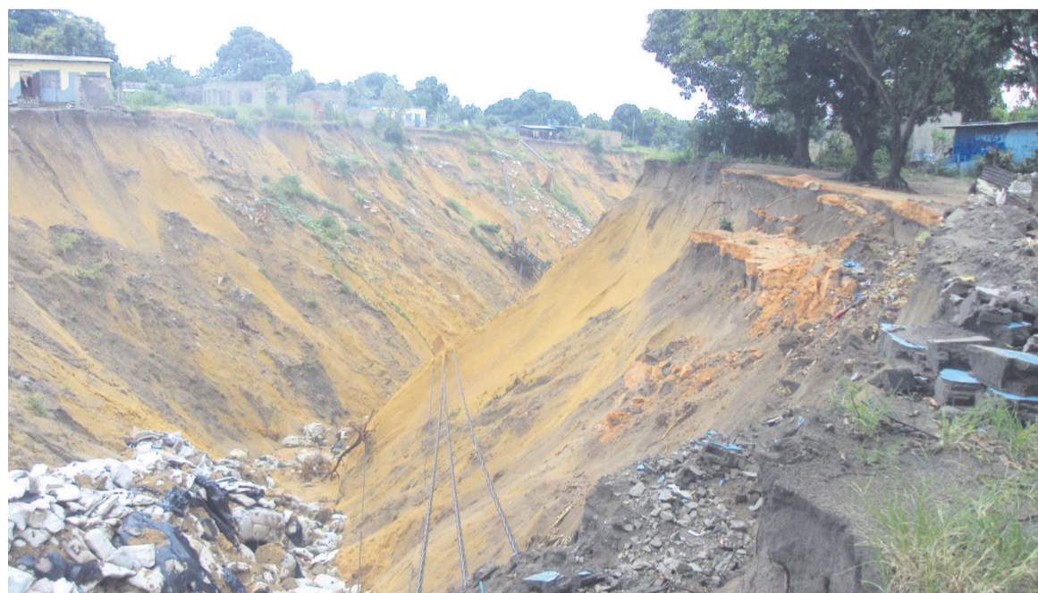
L'érosion a rasé un pylône, sectionnant les câbles ; crédit photo Adiac
