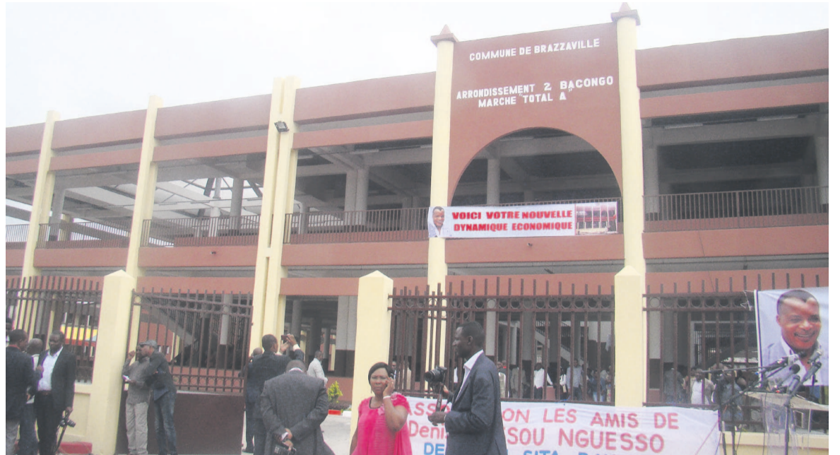
La façade principale
