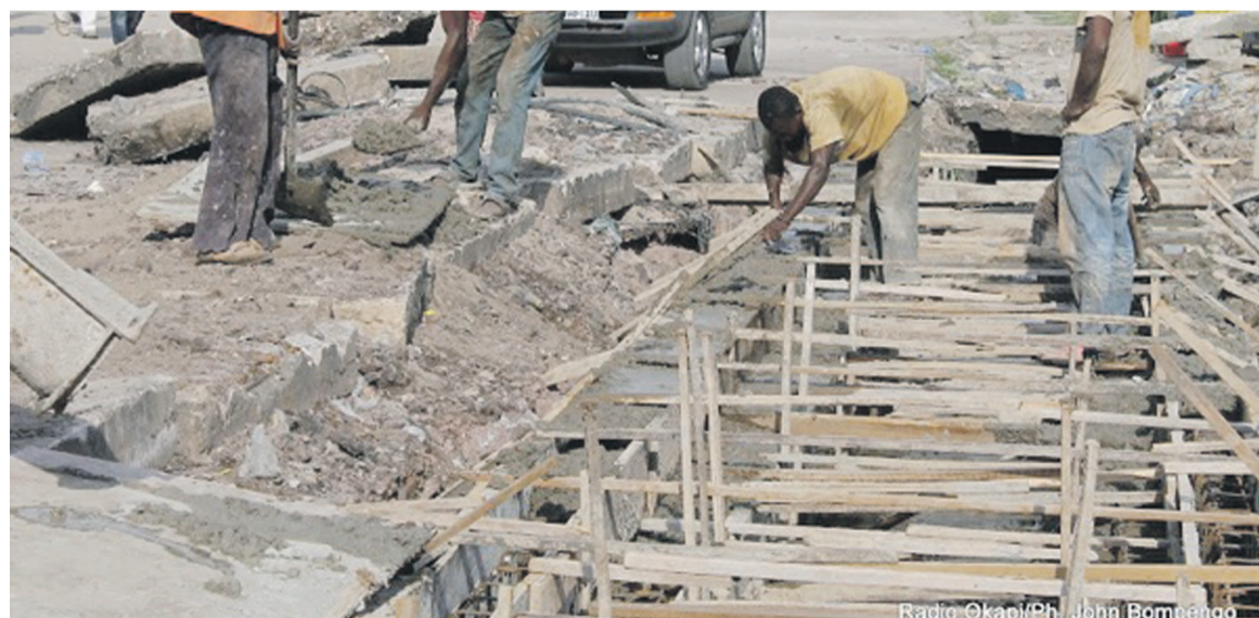
Travaux de réhabilitation des caniveaux, aux abords du stade Tata-Raphaël/Photo John Bompengo-RO
