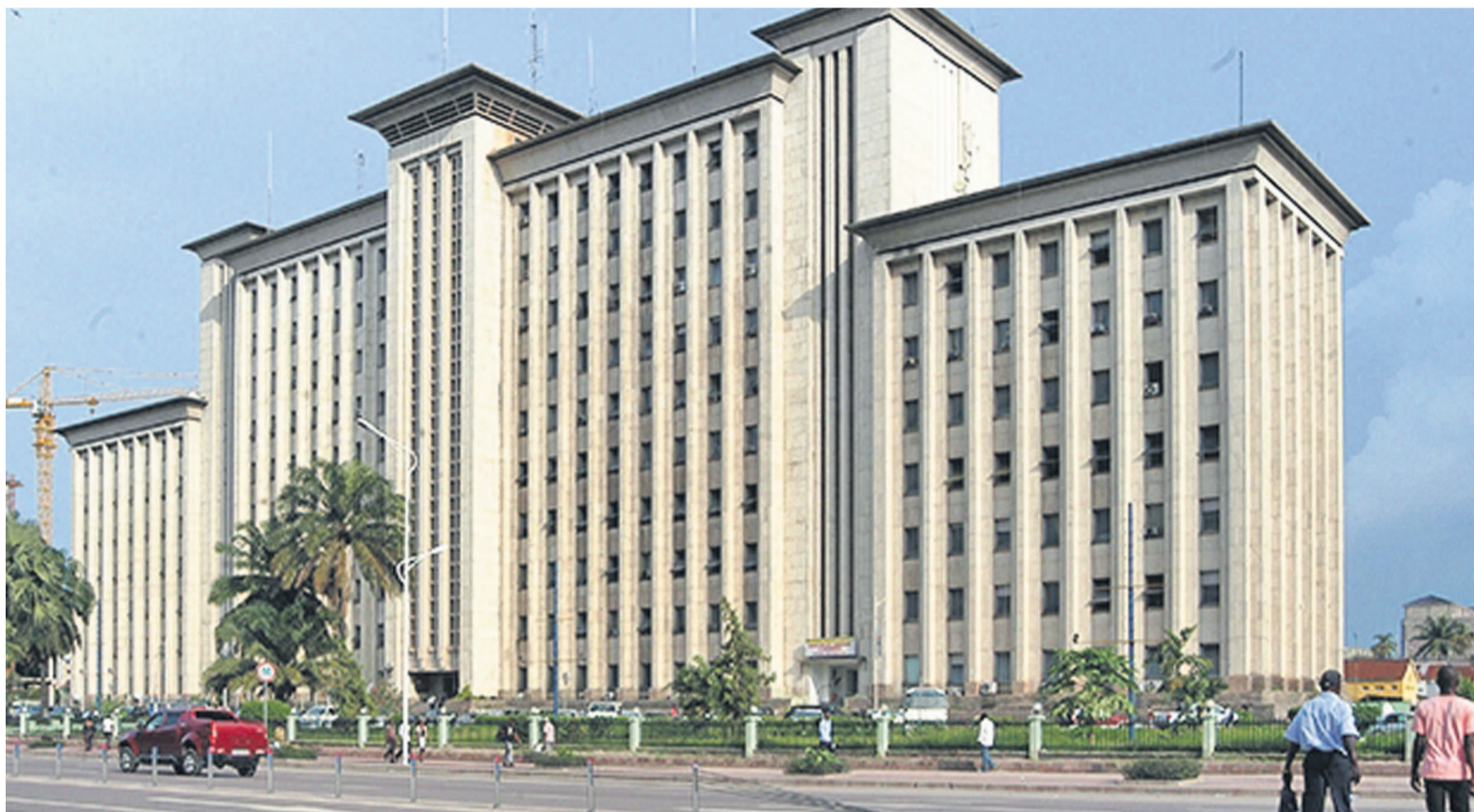
L'immeuble de l'ex-Onatra abritant le ministère des Transports et voies de communication
