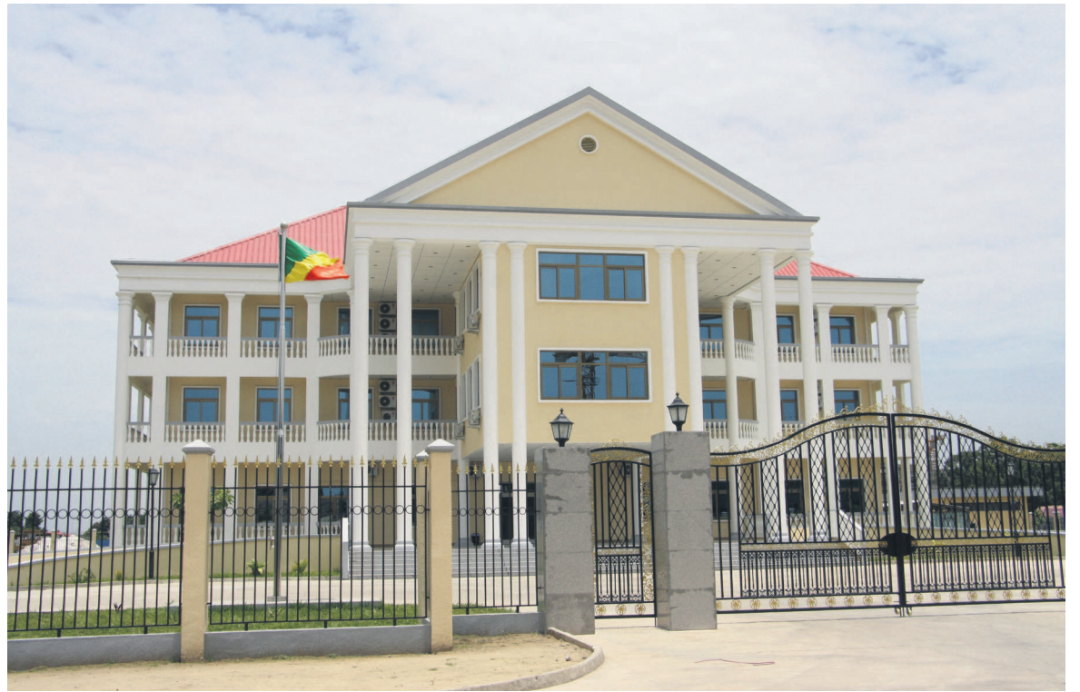
Le futur siège de la mairie de Talangaï, à Mpila
