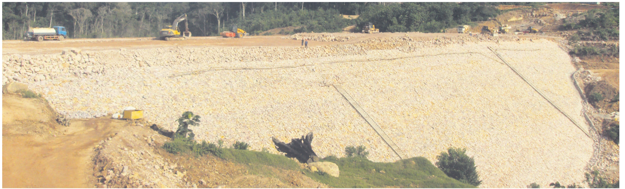
La digue du barrage de Liouesso
