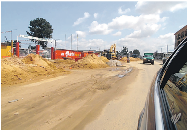
Une vue des travaux de canalisation de l'avenue Jacques Opangault
