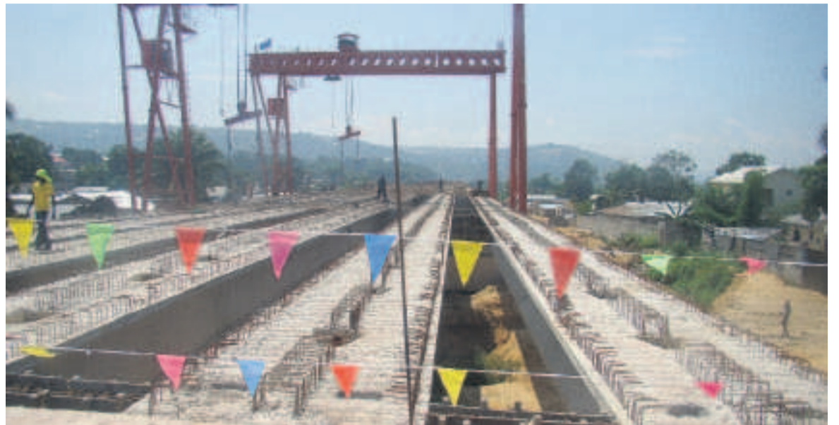
Le viaduc en construction
