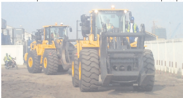
Les deux engins de la Socomab
