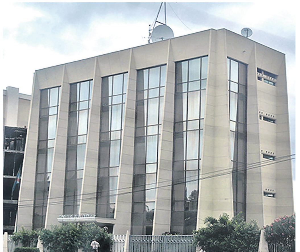
Bâtiment abritant le cabinet du ministre des Finances
