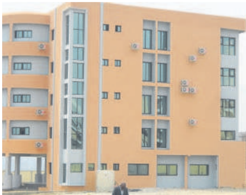
L'un des édifices du village artisanal/photo Adiac
