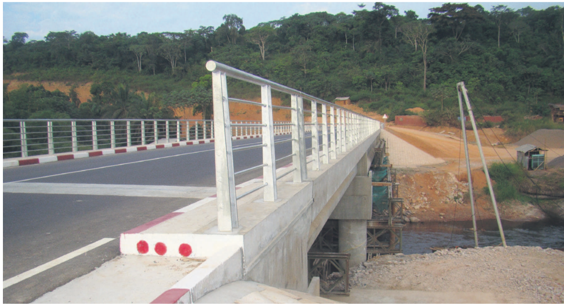
Le pont sur la rivière Liouesso (tronçon Mambili-Ouesso)
