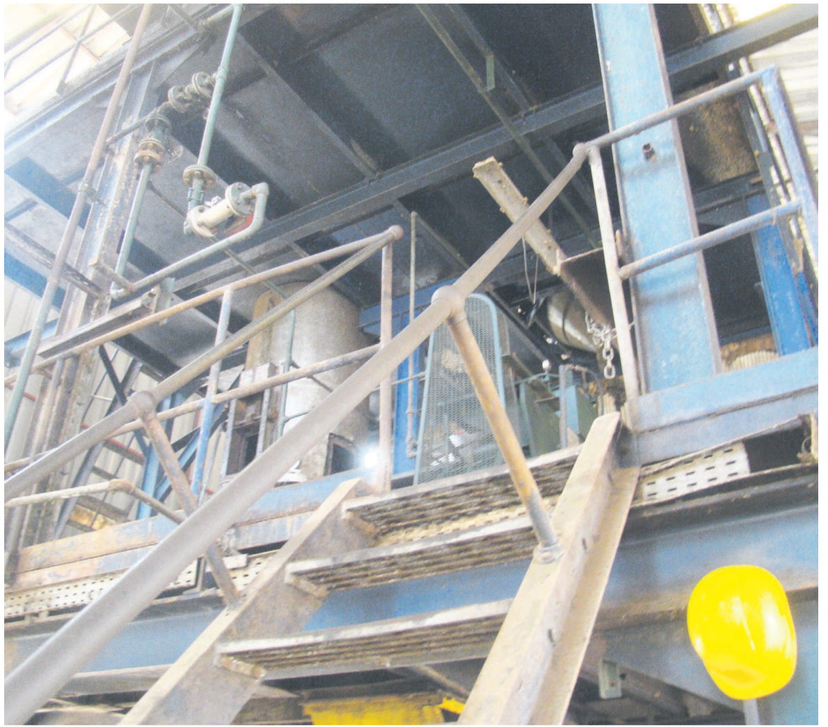
Sur l'ancien site industriel de l'huilerie de Mokeko, Eco Oil a engagé d'importants travaux de réhabilitation de l'usine
