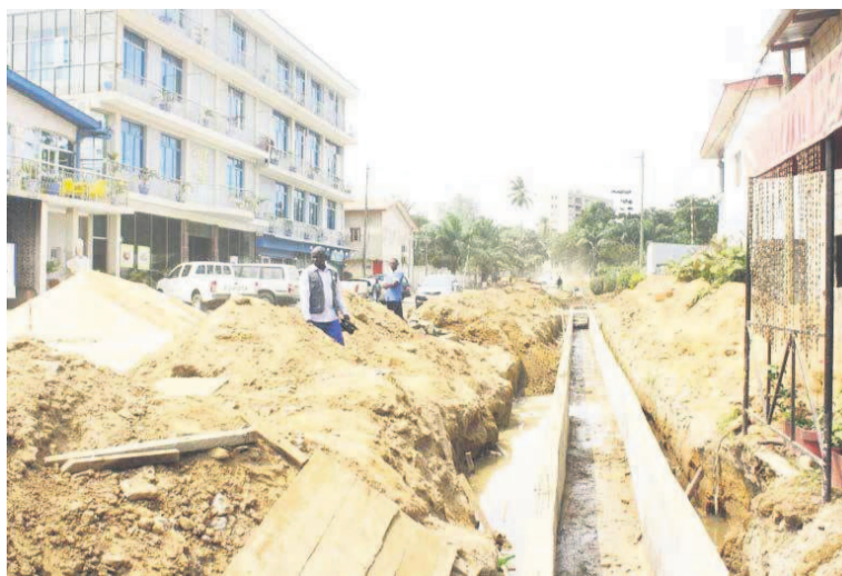
Un des chantiers de construction des caniveaux
