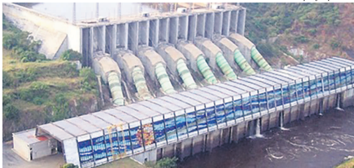
Une vue du barrage d'Inga
