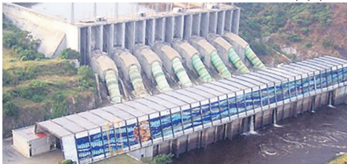
Une vue du barrage d'Inga
