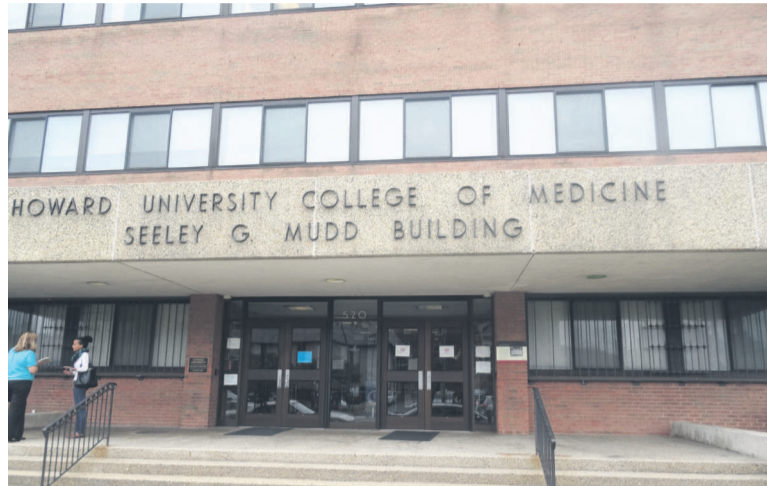
Façade principale du centre
