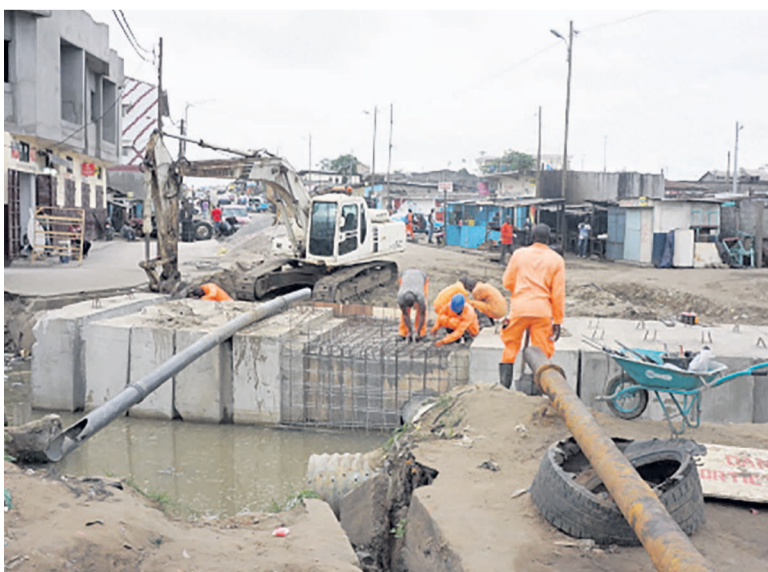
Les travaux du pont sur l'avenue Mâ-Loango
