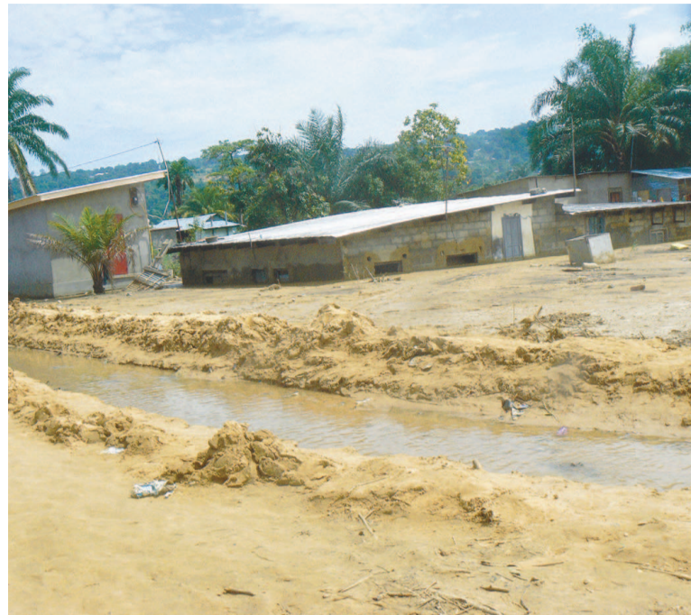
Menace dangereuse pour les maisons du quartier Jacques Opangault (adiac)
