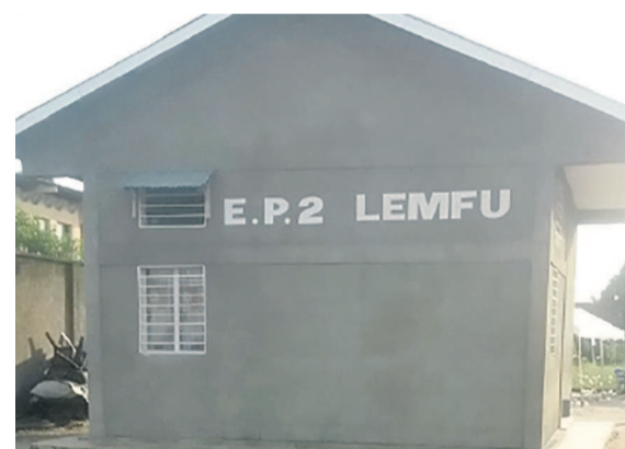
Le bâtiment abritant le bureau d'une école de N'Djili photo Adiac
