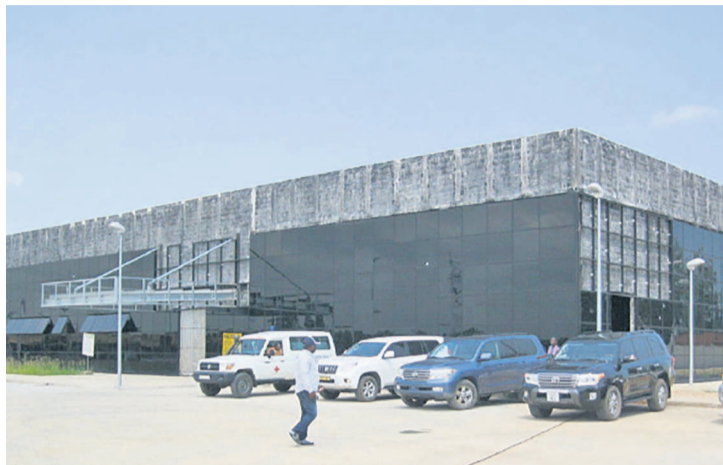
Hôpital général de Pointe-Noire en construction Crédit photo «Adiac»
