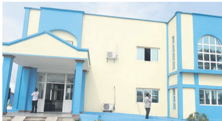
Façade principale de la polyclinique
