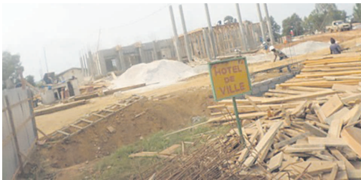
Le chantier de l'hôtel de ville de Madingou (photo adiac)
