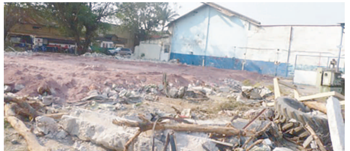
Les travaux de démolition engagés sur les lieux ; crédit photo Adiac
